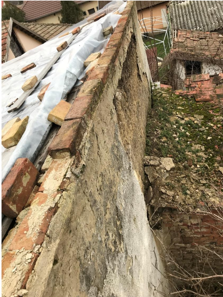
10. Térdfal, és az északi homlokzat részlet
