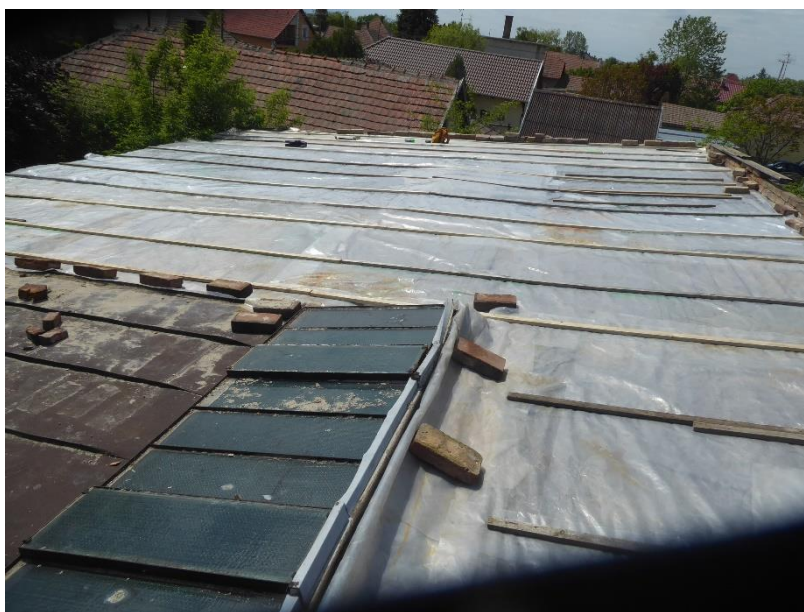
8. A tető az ideiglenes fedéssel, 2023
